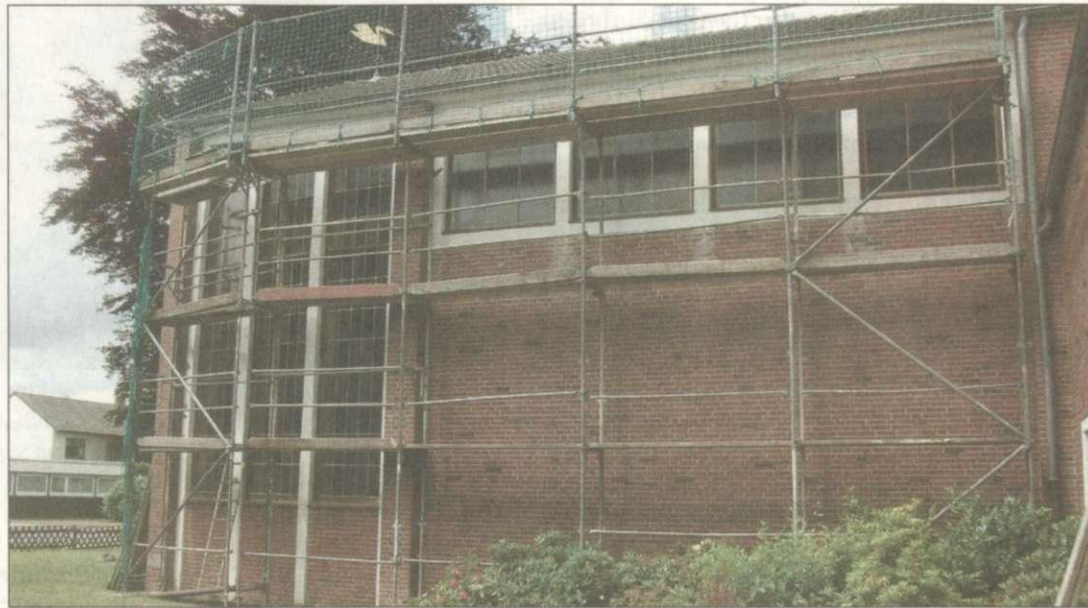
Die Bauarbeiten am Kirchengebäude in Voslapp haben begonnen. Auch von außen ist das durch die Einrüstung deutlich zu sehen.
